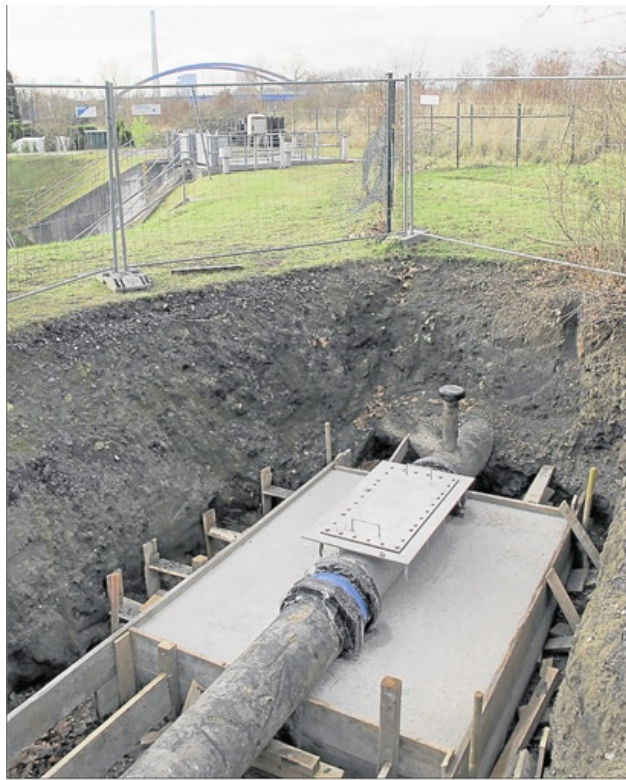
Der Stadtbetrieb Entwässerung (SEB) will das Rohr unter dem Kanal vom Pumpwerk am Weißen Landwehrgraben aus vortreiben. ■ Foto: Brauer
